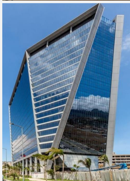
Escritório Icatú Seguros, Rio de Janeiro Cliente: Icatú Seguros Escopo: Certificação LEED-CI (Commercial Interiors)
