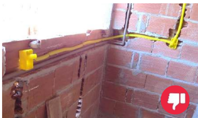
Rasgos na alvenaria para conduítes e tubulação
