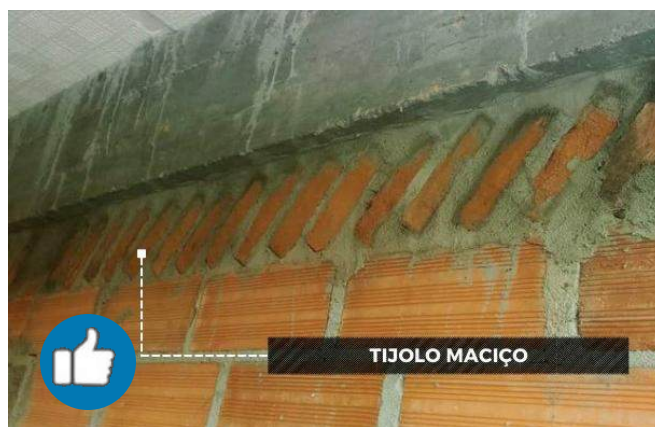
Encunhamento adequado com tijolo maciço ou espuma de poliuretano
