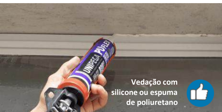
Frestas e danos na caixilharia
